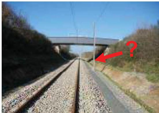
? Des poteaux caténaires sont implantés sur l'axe **qui permettrait pourtant d'installer une seconde voie, si un besoin dans le futur**
